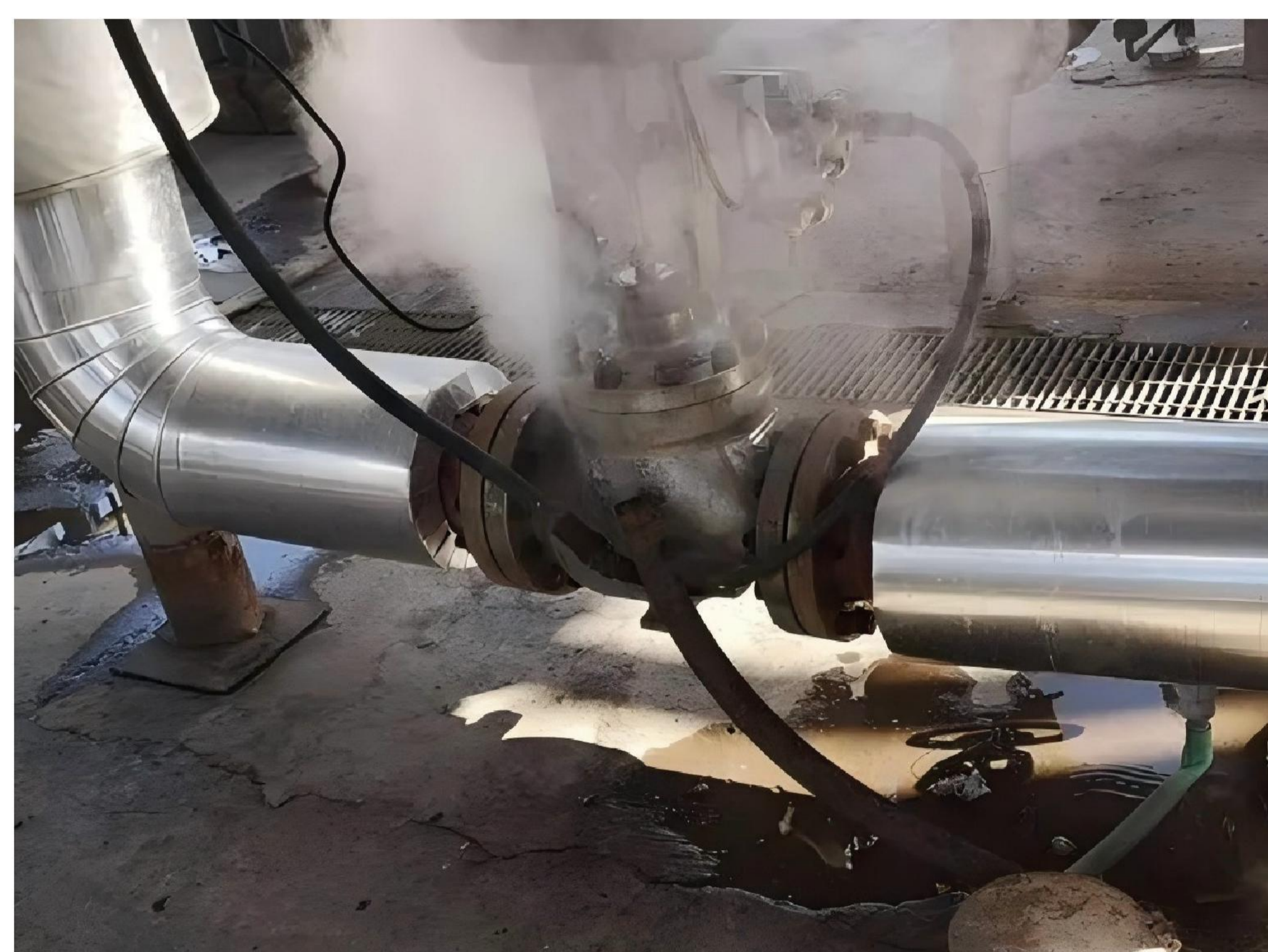
蒸汽伴热恒定温度 防止卡转子
