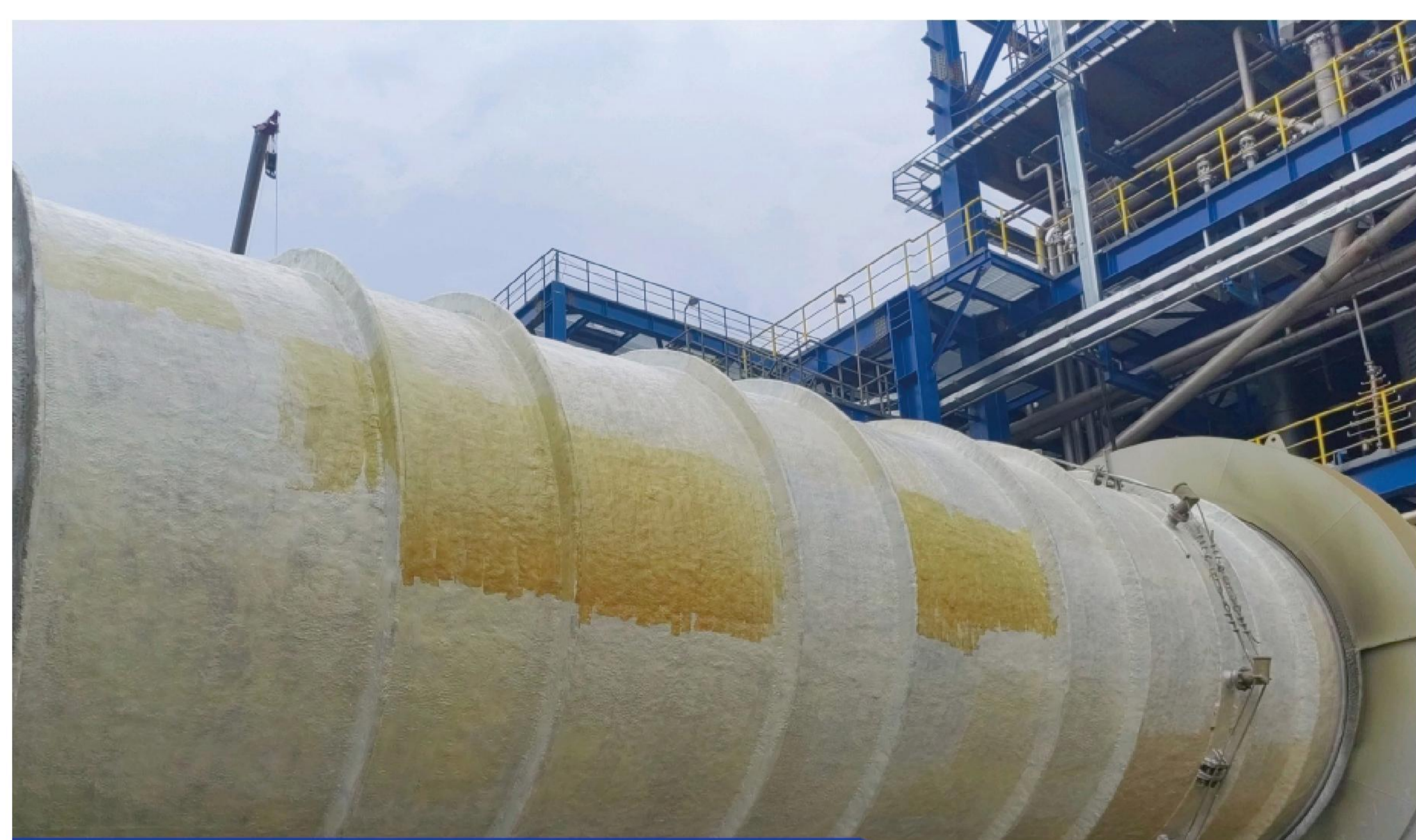
高弹性防水保护层涂料 厚度0.8mm
